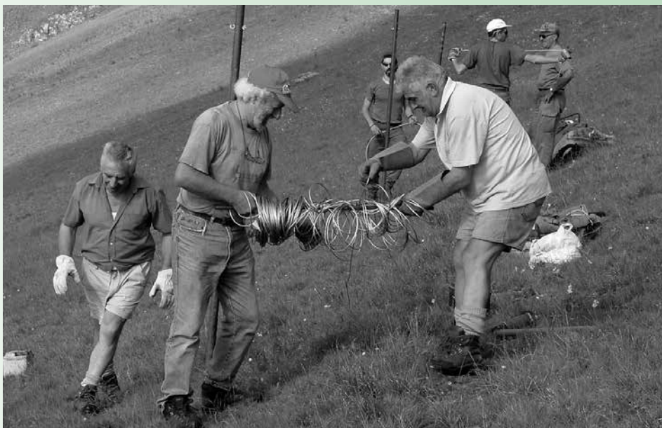
Alcuni soci durante le operazioni di costruzione del recinto per la cattura dei camosci del Barant a luglio 2006. (Foto O. Giordano)
