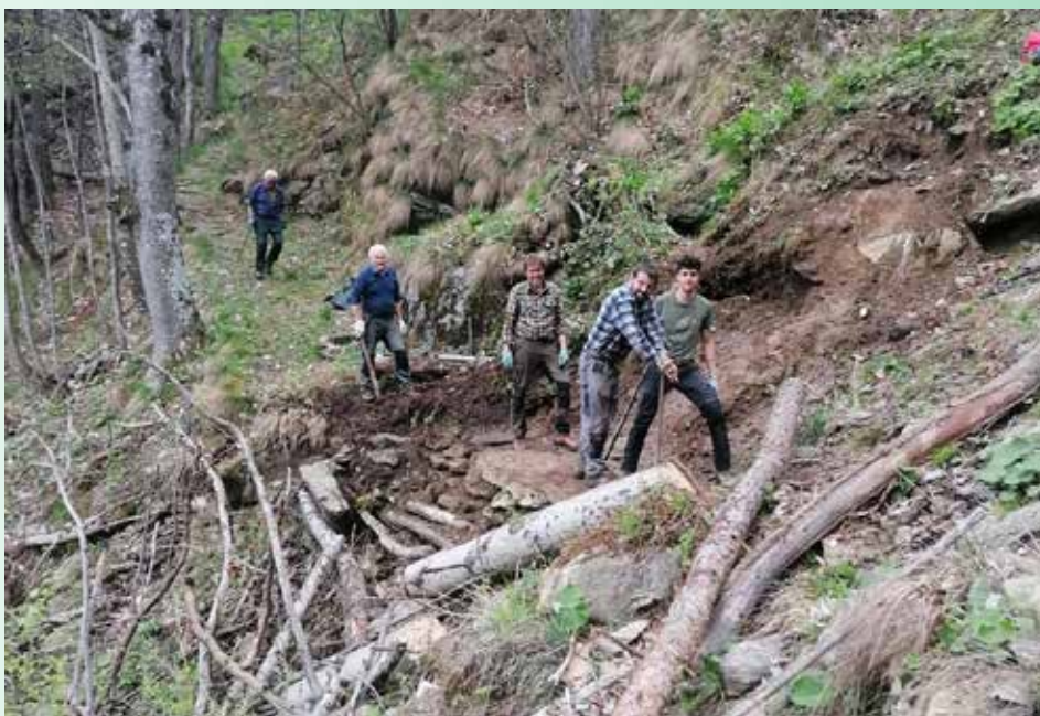
Ripristino di un sentiero franato.
