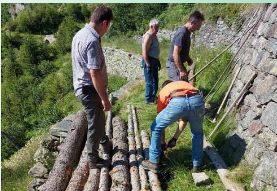
Ricostruzione di una mulattiera franata.
